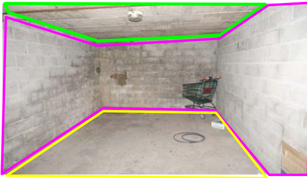
Dalle béton armé, murs parpaings
