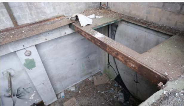
Murs de soutènement béton armé
