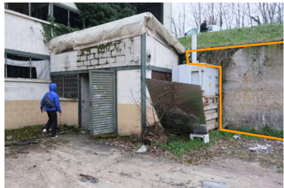
Murs de soutènement béton armé
