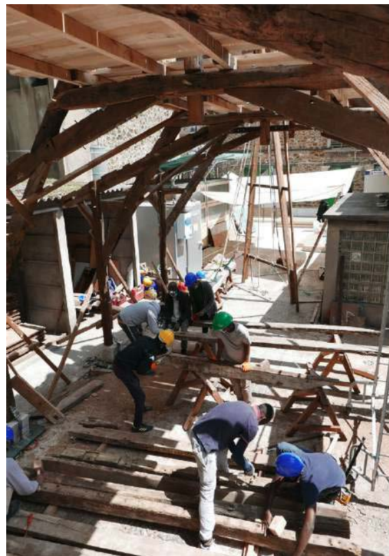
Réemploi d'une charpente en bois pour la création du lieu La Bricole Paris 16ème. Association Aurore, atelier d'architecture A+1 et Laurent Mouly Ingénieur.
